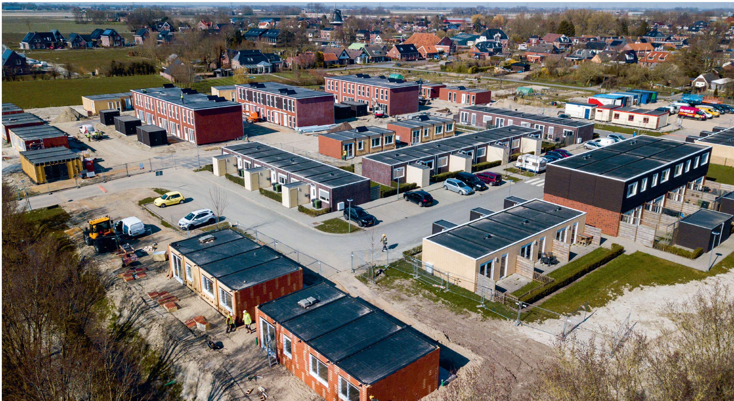
Versterkingsoperatie: Bouw wisselwoningen Loppersum
