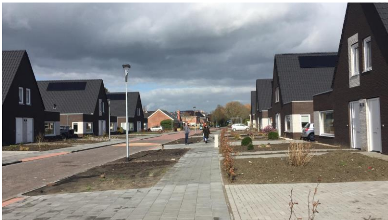
Fig.1: Nieuwbouw28 woningen aan de Klaas Bosstraat in Appingedam, Woongroep Marenland
